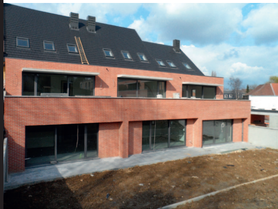
Bouw 16 huurappartementen Vlabinvest
