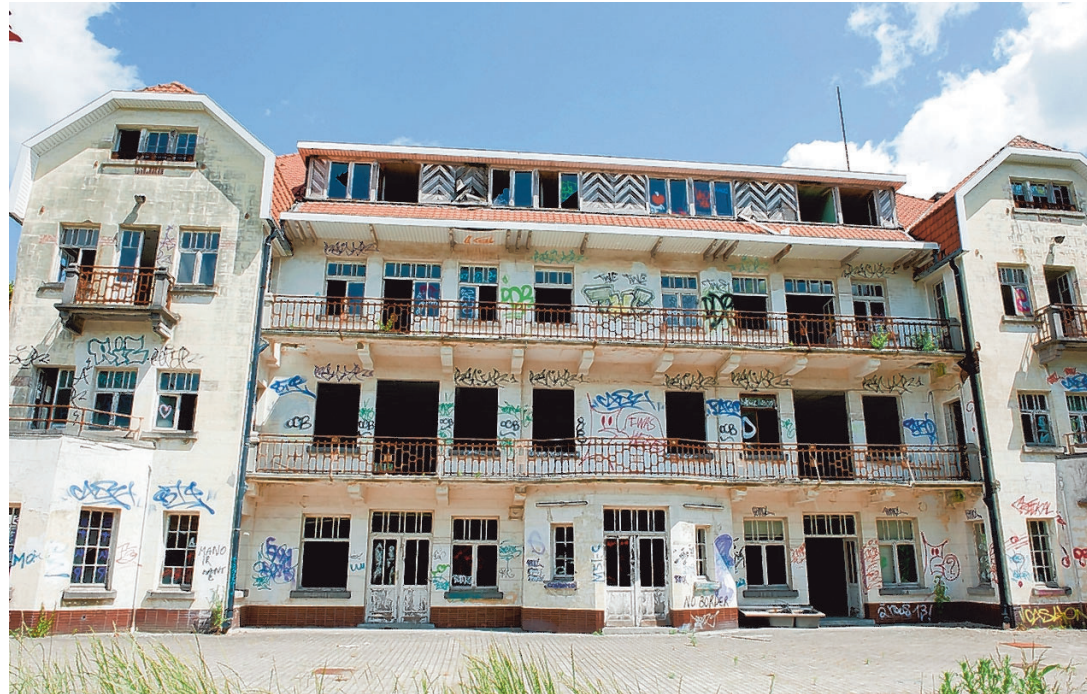
Het gebouw staat al tien jaar leeg en is vervallen. Foto Baert
